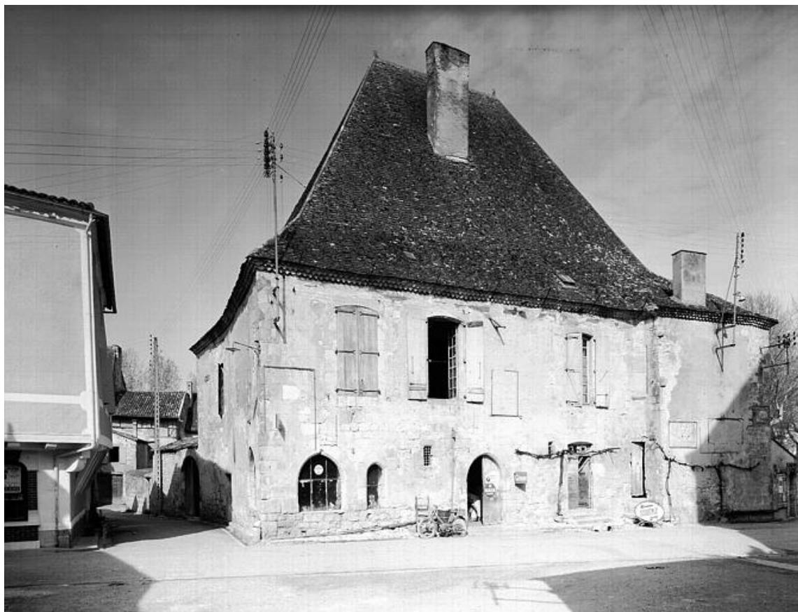
Ancienne prévôté (© Monuments historiques , 1992)
